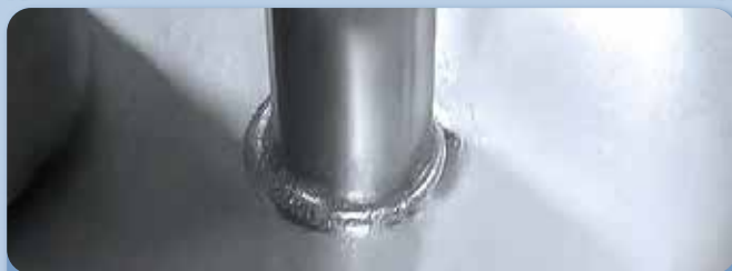
Сварка методом Liquid Flow
